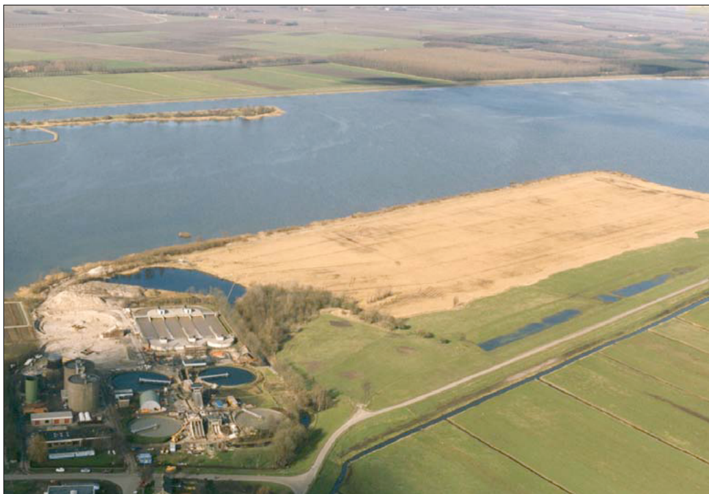
Het Rietveld Elburg en de rioolwaterzuivering in 1993.
